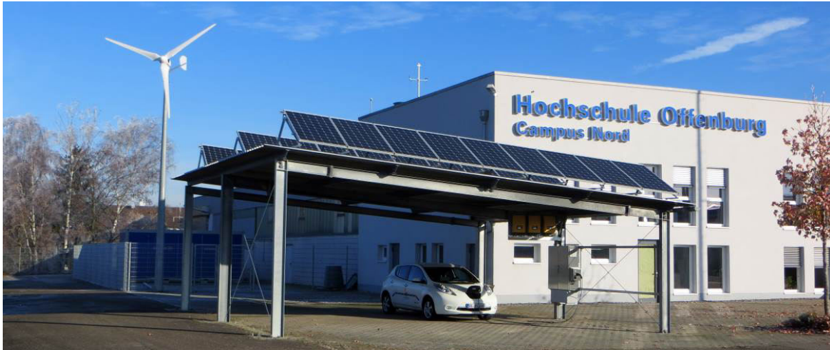
Abbildung 2-43: Außenanlagen und Institutsgebäude am Campus Nord der Hochschule Offenburg.
