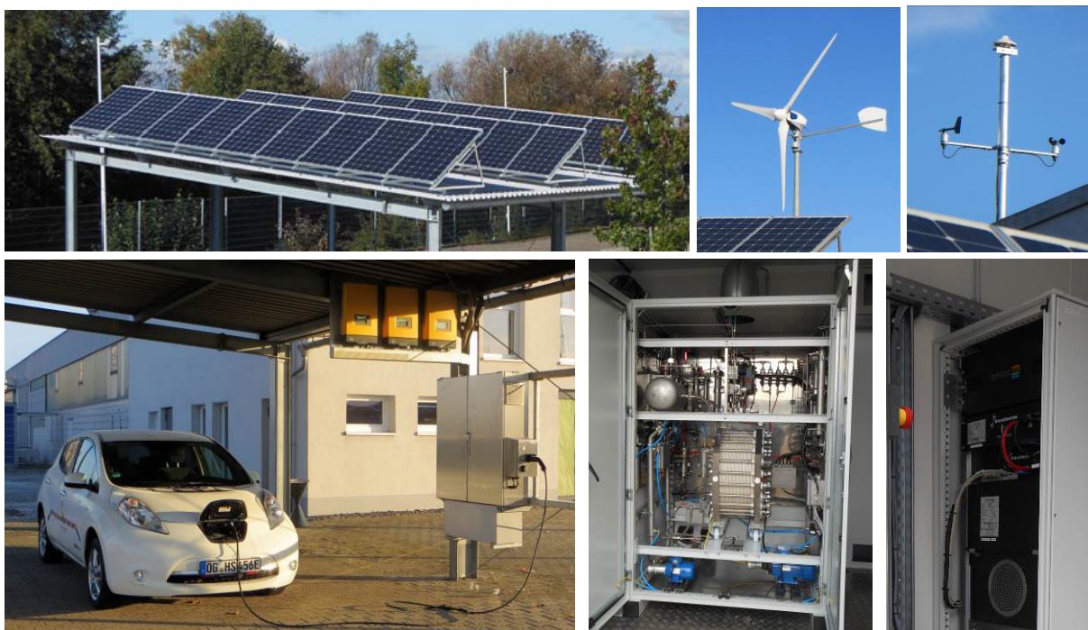
Abbildung 2-45: Komponenten des INES Smart Grid am Campus Nord der Hochschule Offenburg (PV-Generatoren, Klein-Windkraftanlage, Wetterstation, E-Fahrzeug Nissan Leaf mit Ladestation und Wechselrichtergruppe zur PV, Elektrolyseur, Brennstoffzelle).
