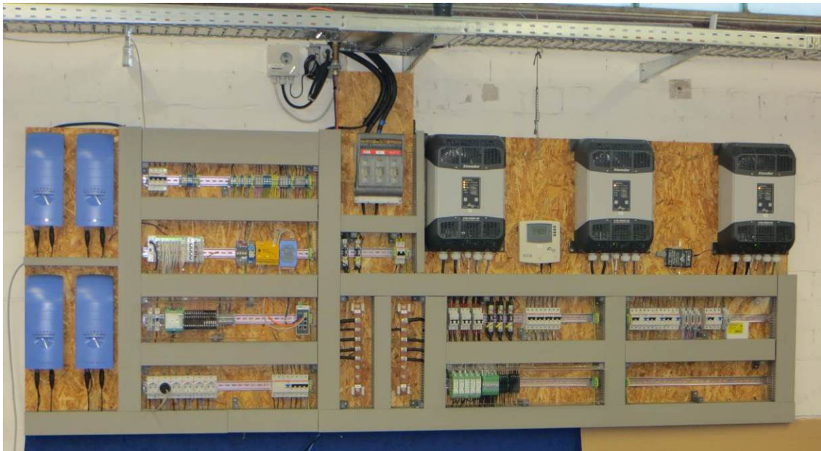
Abbildung 2-47: DC- Verteilung Microgrid mit 48 V-Bleiakkukopplung und drei Netzmanagern zum Aufbau eines dreiphasigen Inselnetzes.
