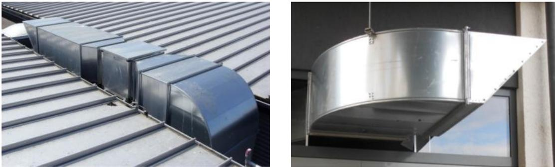
**Abbildung 3.3-1: Abluftanlage mit Schalldämpfereinheit, DG der Oststadtschule (links) und Fortluftauslass im 2.OG der Oststadtschule (rechts)**
