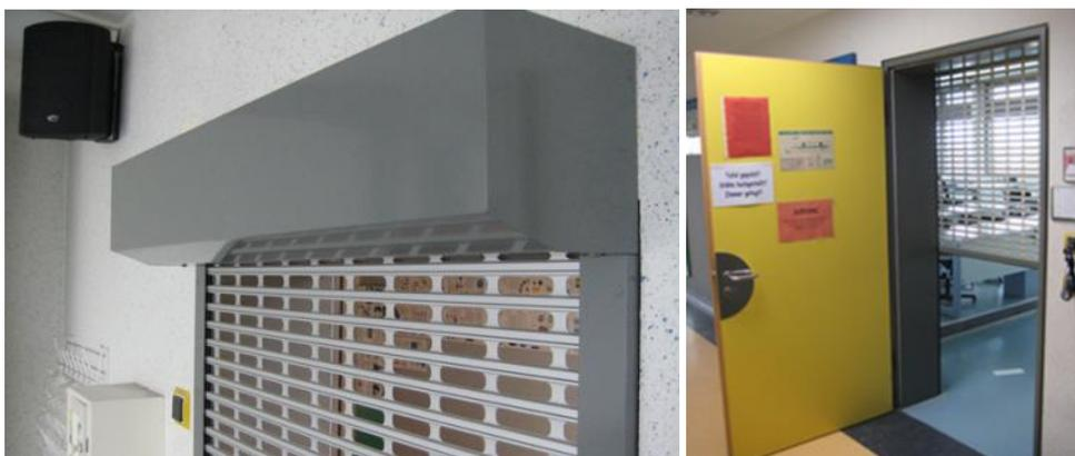
**Abbildung 9.2-9: Rollläden mit ausgestanzten Metallsegmenten zur Integration von Sondernutzungsbereichen in zentrale Nachtlüftungskonzepte (li: Montage im Innenbereich des Fachraums, re: Zugang zum Flur gesichert)**
