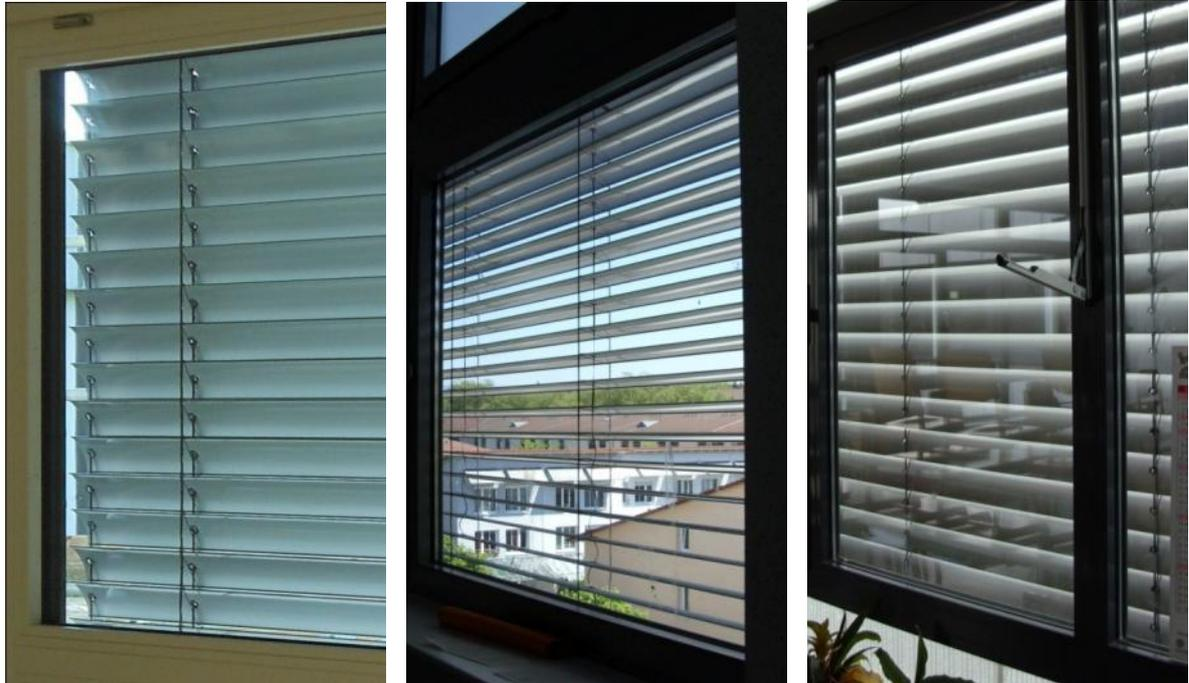
**Abbildung 9.2-1: Sonnenschutz bei tiefstehender Sonne und verbesserter Wärmeschutz, bevorzugt im Winter (links)**
