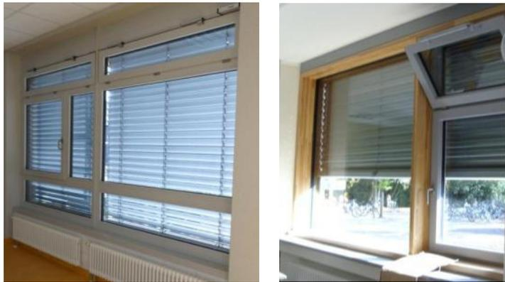
**Abbildung 3.2-2: Einheitliche Gestaltung der Fensterfront der Schule Weier (links) mit Festverglasung, Hauptfenster zur Stoßlüftung und elektromotorisch steuerbaren Oberlichtfenstern als Doppelsegment**
