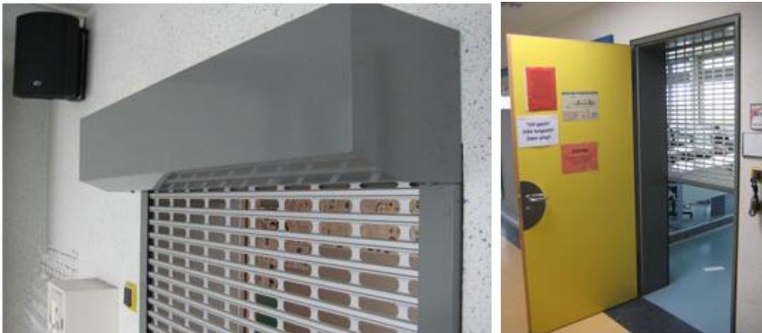
**Abbildung 6: Aufgesetzte Rollläden mit ausgestanzten Metallsegmenten (links: Innenseite des Fachraums mit Rollladenbox, rechts: Klassenzimmertür zum Flur öffnend und Blick in den Fachraum bei teilweise geöffnetem Rollladen)**
