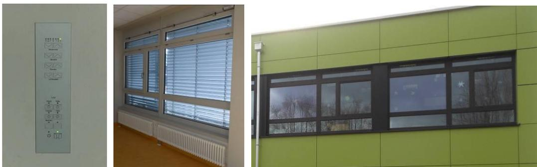
**Abbildung 10: Bedienpanel, heruntergefahrne Jalousien und zwei Fenstersegmente mit Festverglasung, Oberlicht und Hauptfenster.**
