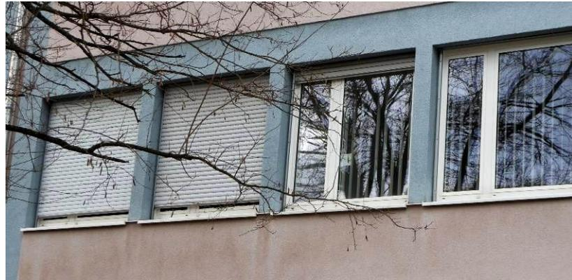
**Abbildung 6: Fenstersegment des Fachklassentrakts mit Außenjalousien, Festverglasung, Hauptfenster und Oberlicht (links).**
