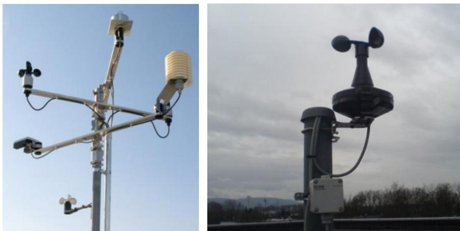
**Abbildung 3.4-1: Wettermesstechnik zur Überwachung über die Gebäudeautomation (Links: Wetterstation der Oststadtschule)**
