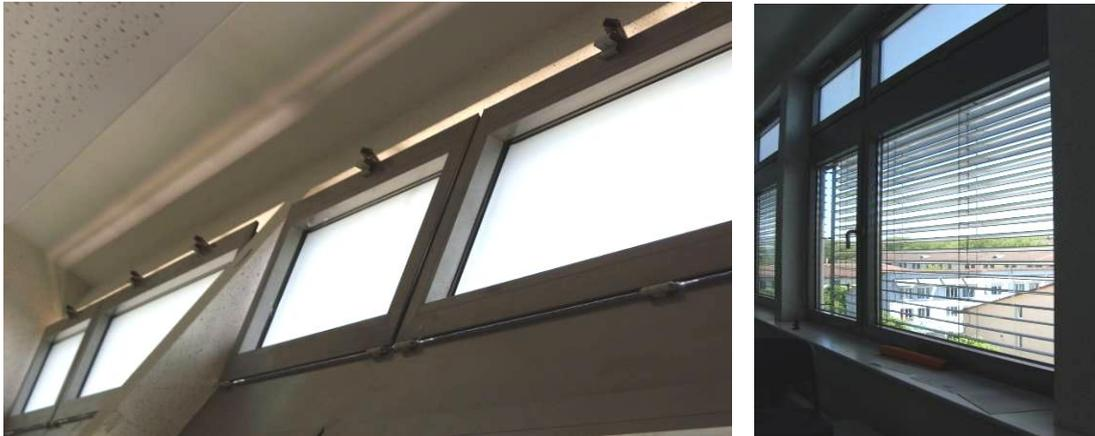
**Abbildung 7: Beschichtete/beklebte Oberlichter im Dachgeschoß (links).**
