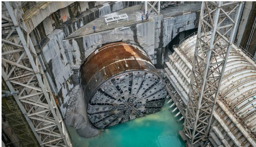
Abbildung 1: weltgrößte Tunnelbohrmaschine, Quelle: [7]
