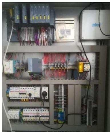
Abbildung 4: Schaltschrank mit ET200.
