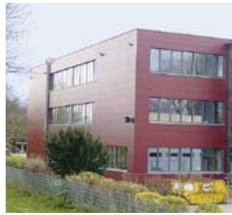
Abb. 3.6-9: 2010 sanierte Gebäudehülle der Konrad-Adenauer-Schule
