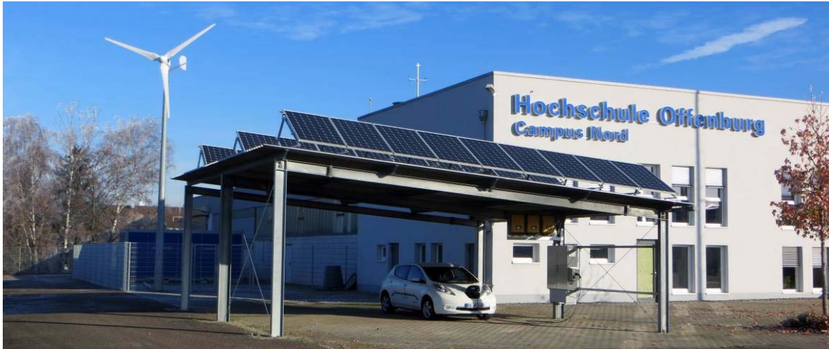
Abbildung 3: Außenanlagen und Institutsgebäude am Campus Nord der Hochschule Offenburg.
