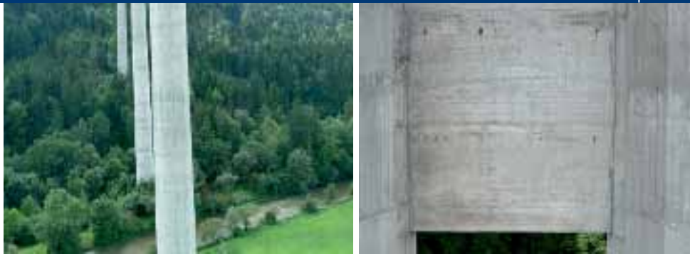
Abb. 3: Aufnahmen vom Flug an der Neckartalbrücke
